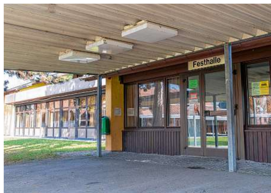
Sanieren und umbauen oder abreißen und neu bauen lautet die Frage bei der Festhalle Fischbach. BILD: GISELA KELLER
